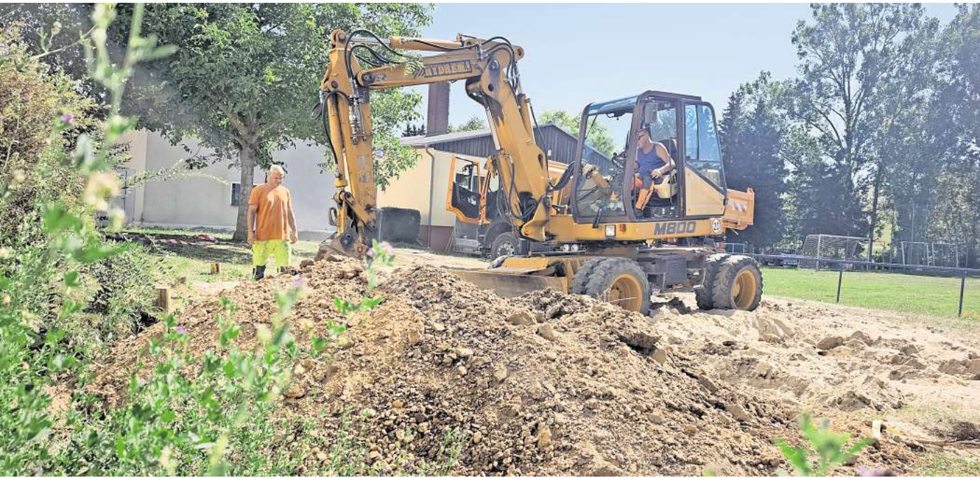
In Nöbdenitz wird gebaut: Der Spielplatz wird erneuert.
