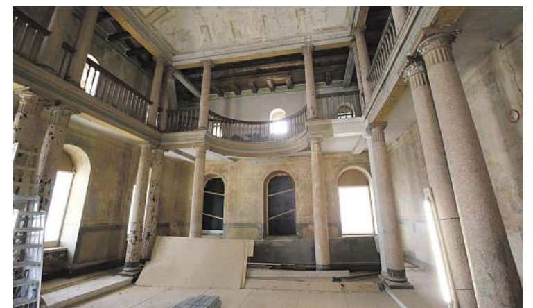
Blick in den Altbau
