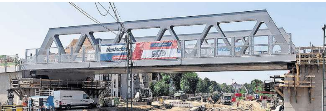
In Betrieb genommen wurde dieser Tage die neue Bahnbrücke in Sellerhausen. Foto: Dr. Jürgen Findeisen/DB InfraGO
