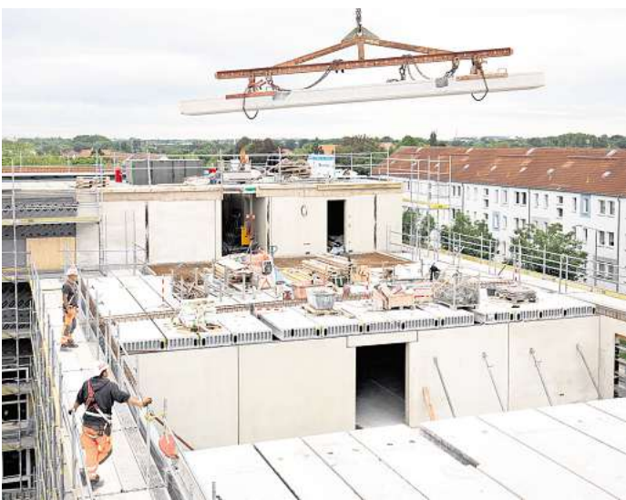
Es geht voran in der Essener Straße: Beim Projekt von 121 neuen Seniorenwohnungen konnte die LWB in diesen Tagen Richtfest feiern. Foto: Peter Usbeck/LWB
