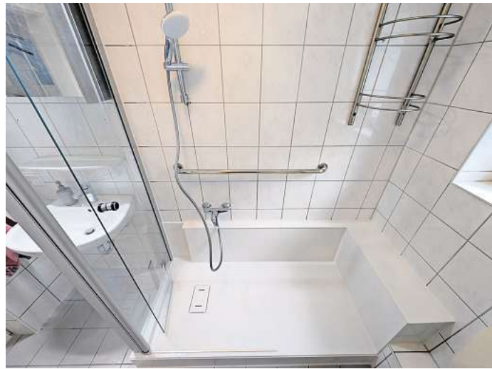
AN NUR EINEM ARBEITSTAG entsteht aus der alten hohen Dusche eine neue Dusche mit flachem Einstieg. Die alte Wanne wird inklusive der Verkleidung sauber entfernt und durch eine neue Dusche ersetzt. Foto: BADbarrierefrei
