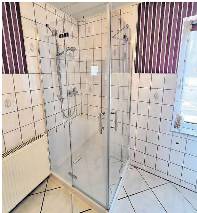
AN NUR EINEM ARBEITSTAG entsteht aus der alten hohen Dusche eine neue Dusche mit flachem Einstieg. Die alte Wanne wird inklusive der Verkleidung sauber entfernt und durch eine neue Dusche ersetzt. Foto: BADbarrierefrei
