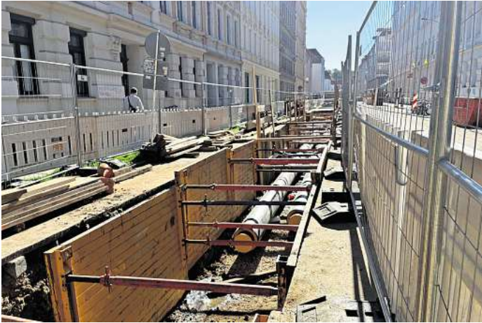
Diese (Baustellen-)Bilder prägen derzeit die Leipziger Südvorstadt: Hier investiert die L-Gruppe in die Erweiterung des Fernwärmenetzes.
