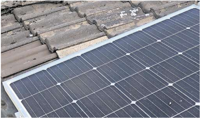
Welche Schadensrisiken lauern bei der Sanierung von Wohngebäuden? Die Experten vom Bauherren-Schutzbund geben die Antworten. Foto: BSB
