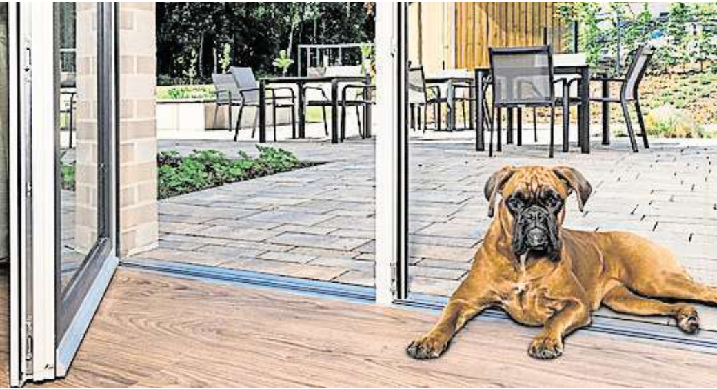
SCHWELLEN - ETWA ZUR TERASSE - sollte man ebnen. So bleibt das Wohnen im Alter komfortabel und sicher. Foto: Verband Fenster + Fassade e.V.
