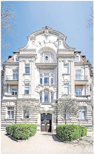
Das AZURIT-Seniorenzentrum Palais-Balzac in Leipzig bietet freundlich gestaltete Zimmer in einem modernisierten Wohnumfeld. Foto: AZURIT
