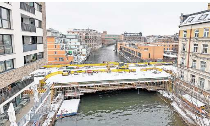
So sah die Baustelle der Karlbrücke noch im Februar diesen Jahres aus. Foto: Wolfgang Sens
