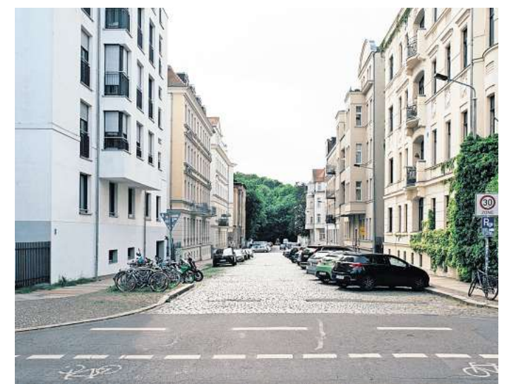
Die Förderung für das Modellprojekt ist da: Die Steinstraße zwischen August-Bebel-Straße und Brandvorwerkstraße wird zum wassersensiblen Straßenraum. Foto: Niclas Tiedemann
