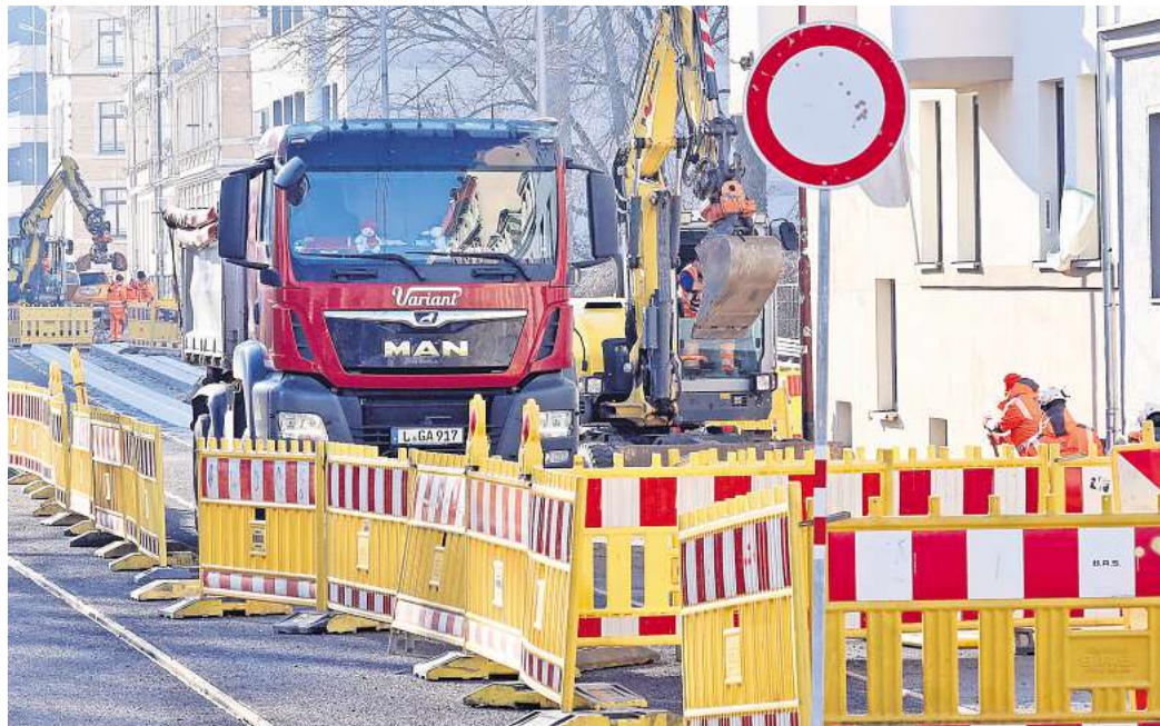
Was für eine Großbaustelle! In der Dieskaustraße läuft aktuell ein für alle Seiten herausforderndes Projekt. Immerhin: Gut die Hälfte ist geschafft, der Bauabschnitt an der Radrennbahn ist fertig. Foto: André Kempner
