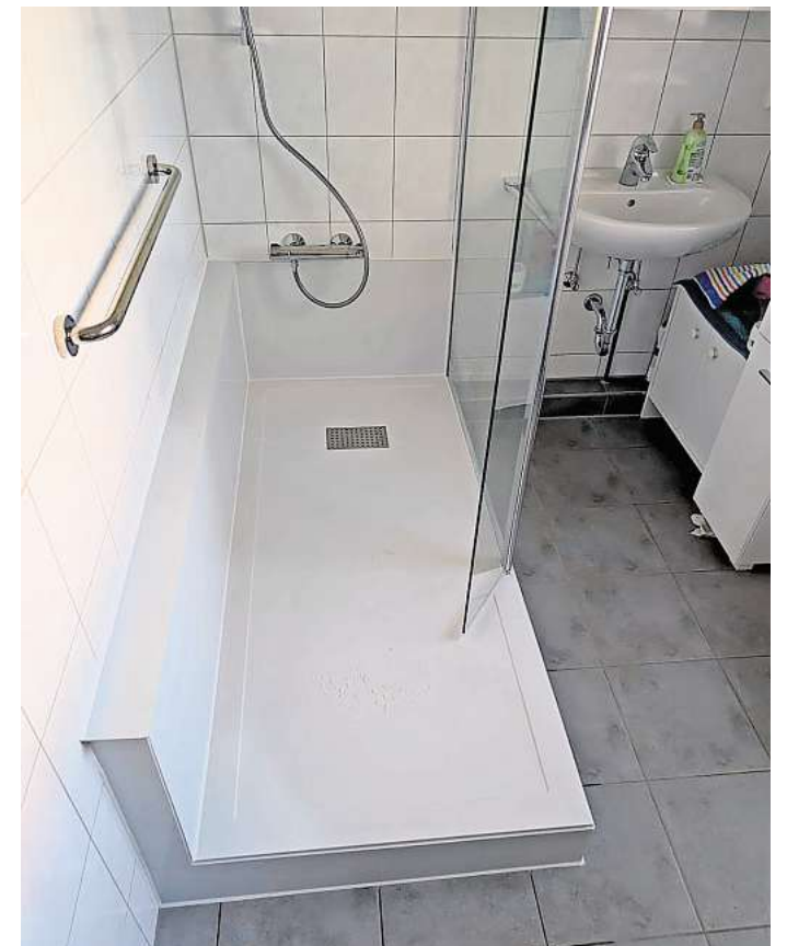
MORGENS NOCH eine alte Badewanne, abends eine geräumige Dusche – möglich macht dies das Umbau-System „Wanne zur Dusche“. Foto: BADbarrierefrei
